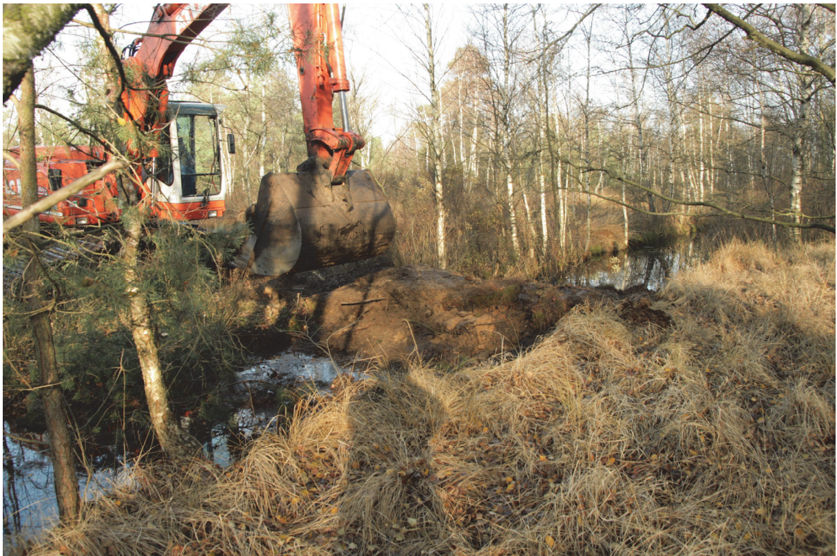
Foto: Entwässerungsgraben wird geschlossen
