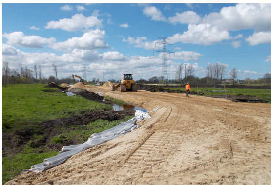
Vorarbeiten für die Baustraße der A26 in Neu Wulmstorf – April 2014
