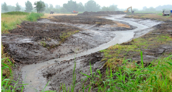
Fast fertig gestellte Grabenaufweitung © Andreas Warming / Grontmij GmbH
