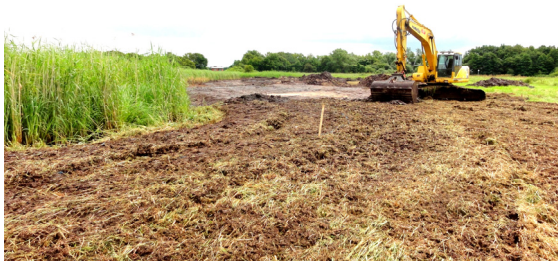
Während der Herstellungsarbeiten © Andreas Warming / Grontmij GmbH
