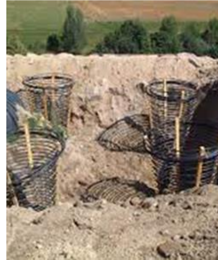
Quelle: Steininger Gebäudetechnik
