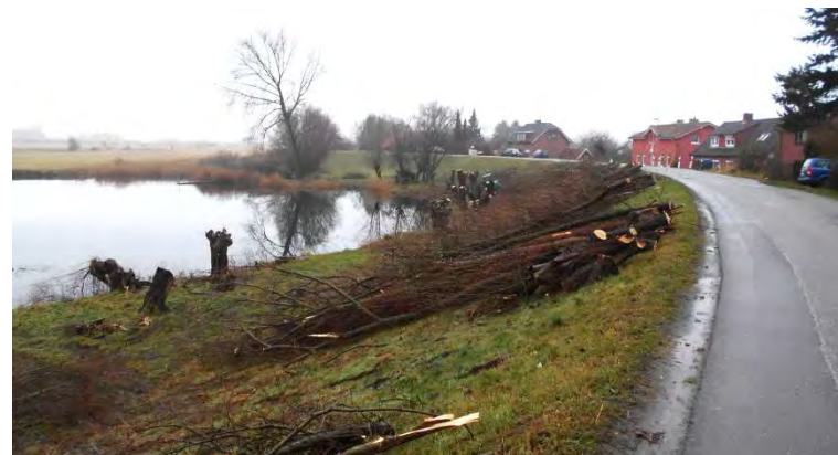
Nach Abschluss der Arbeiten © Maik Bösch / Landkreis Harburg
