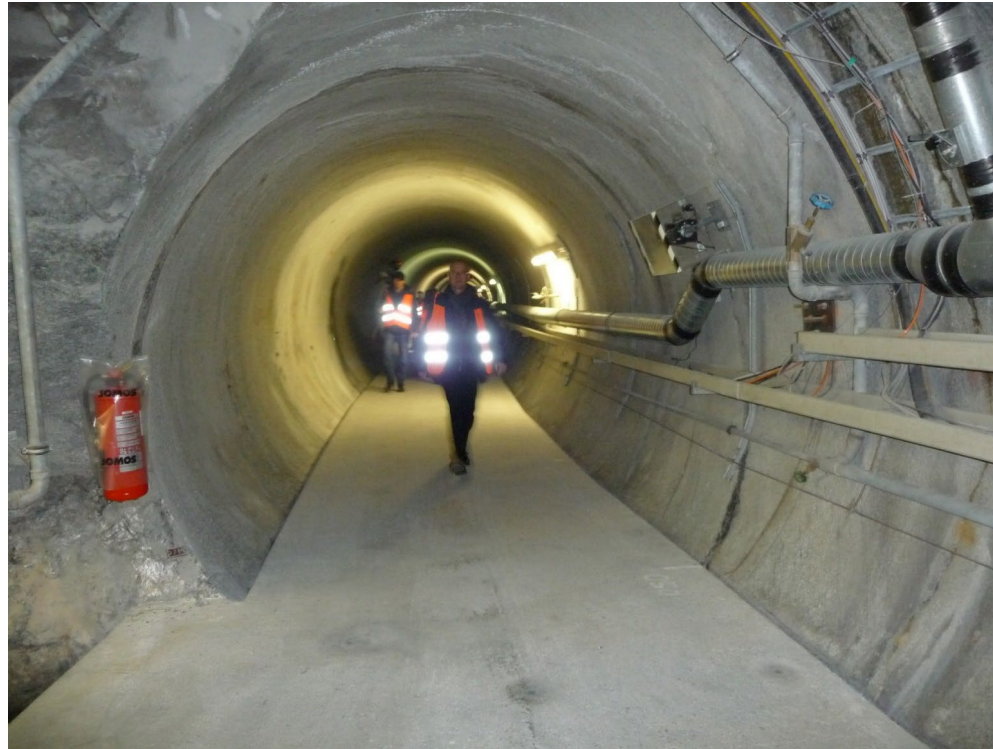
▲ Tunnel im Granit (Felslabor Grimsel, Schweiz)
