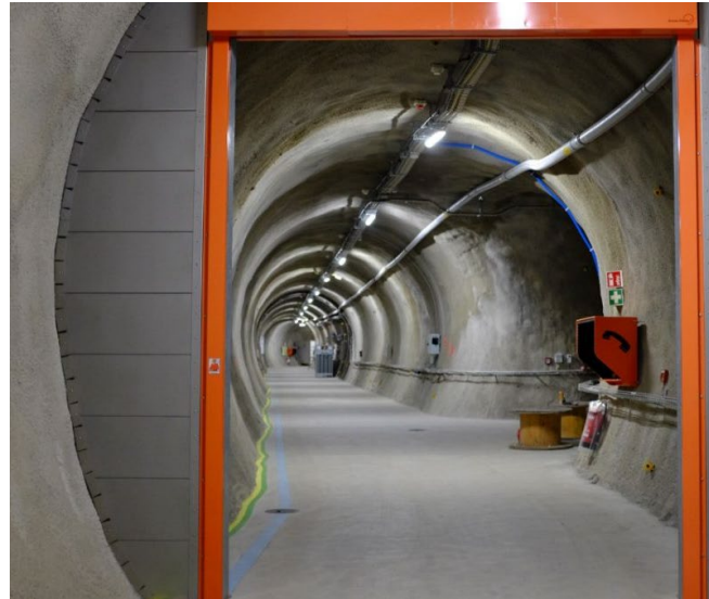
▲ Spritzbetonauskleidung im Felslabor Mont Terri, Schweiz
