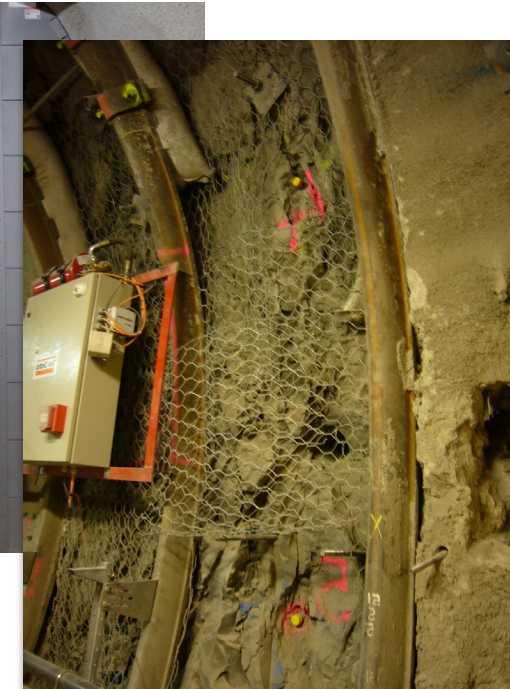
▲ Anker und Ausbau im Untertagelabor Meuse/Haute-Marne, Frankreich
