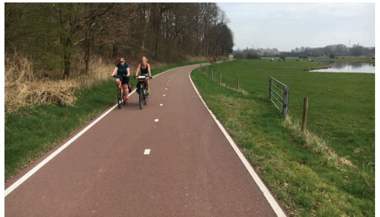
Zielbild selbstständig geführter Zweirichtungsradweg (Beispiel aus Nijmegen/Niederlande)
