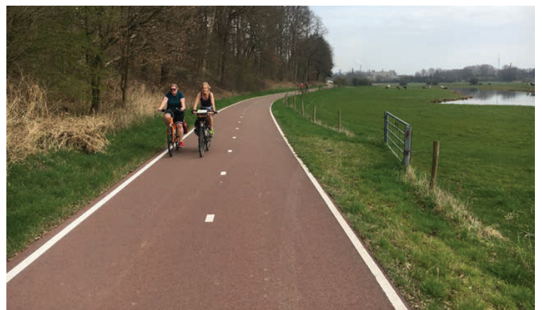
Zielbild selbstständig geführter Zweirichtungsradweg (Beispiel aus Nijmegen/Niederlande)
