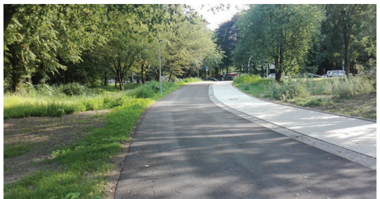
Zielbild selbstständig geführter Zweirichtungsradweg mit parallelem Gehweg (Beispiel aus Hamburg; Quelle: ARGUS)
