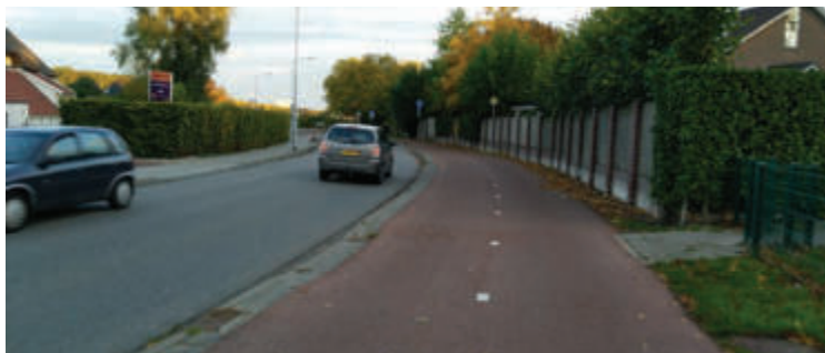
Zielbild straßenbegleitender Zweirichtungsradweg (Bsp. aus Weurt/Niederlande)
