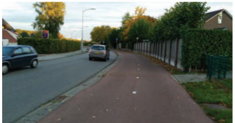
Zielbild straßenbegleitender Zweirichtungsradweg (Bsp. aus Weurt/Niederlande)
