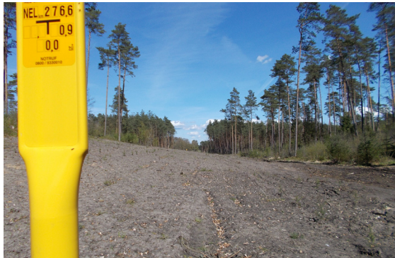
Leitungstrasse durch den Wald bei Scharmbeck
