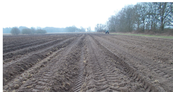
Herstellung der Pflanzwälle auf der Aufforstungsfläche
