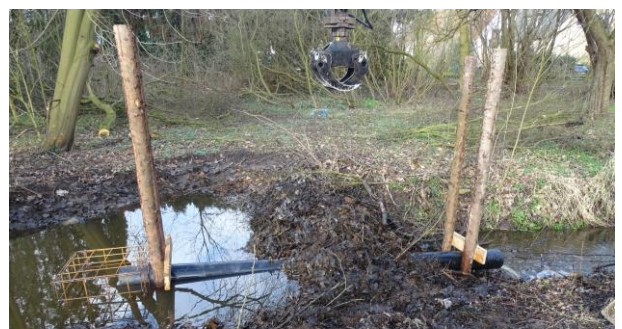
Biberbau mit Drainage © Isabelle Heidemann / Landkreis Harburg
