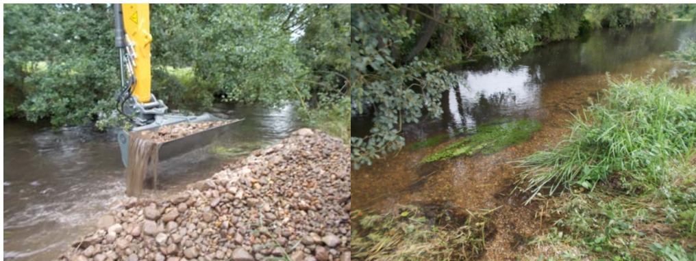
Einbringen von Kies in die Seeve © Henryk Ochmann Aufwerteter Seeveabschnitt © Henryk Ochmann
