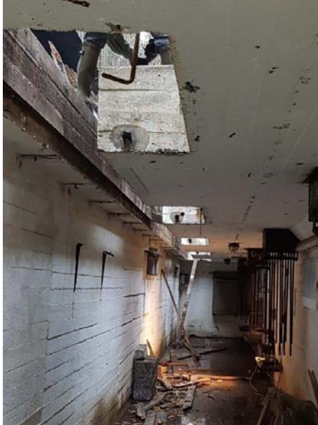
Bunker in der Umbauphase
