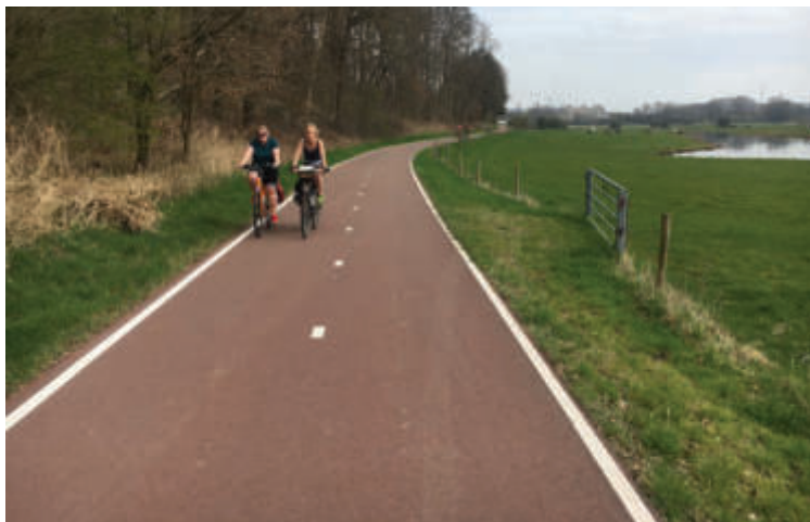
Zielbild selbstständig geführter Zweirichtungsradweg (Beispiel aus Nijmegen/Niederlande)
