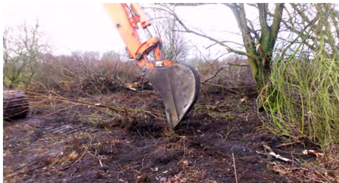
Mit Maschineneinsatz wurde die Traubenkirsche zwischen den erhaltenswerten Gehölzen vollständig entfernt
