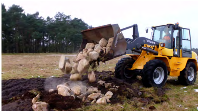
Steinschüttungen mit Hilfe eines Radladers © Landkreis Harburg
