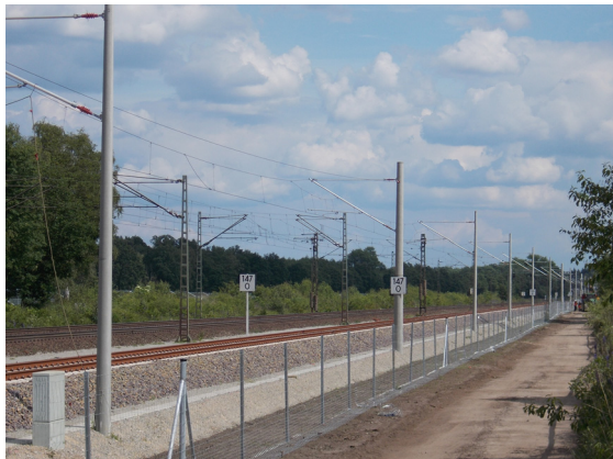
Fertiggestellter Wildschutzzaun Juni 2014 © Landkreis Harburg
