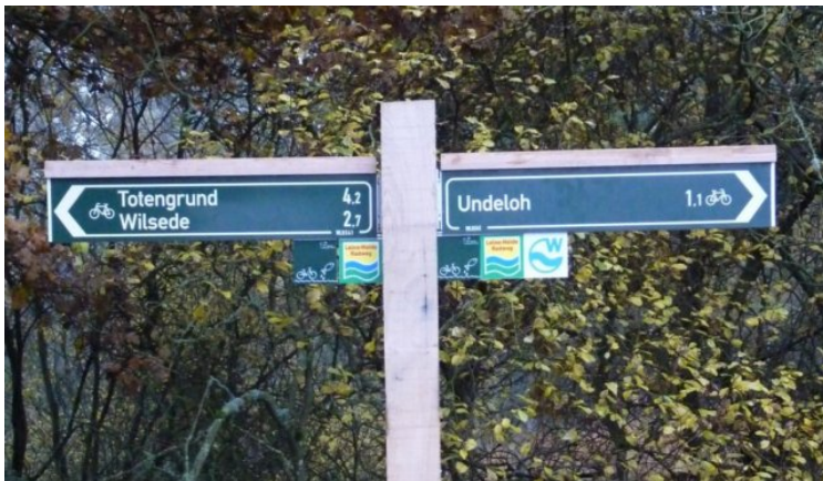
Beispiel Zielwegweiser mit diversen Zusatzplaketten an Vierkantpfosten
