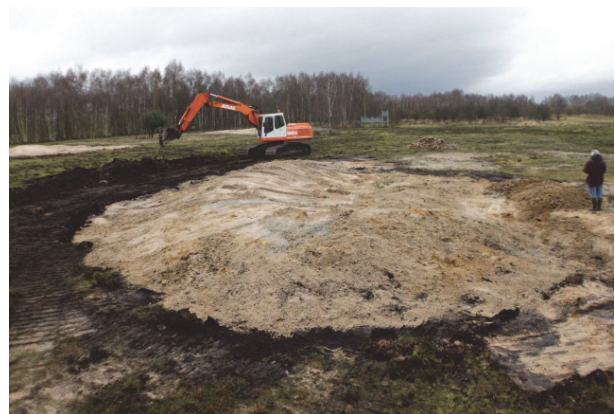
Foto: Mit einem Bagger werden offene Sandflächen geschaffen
