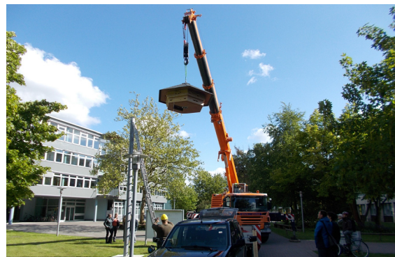
Aufbau des Mauersegler-Hotels
