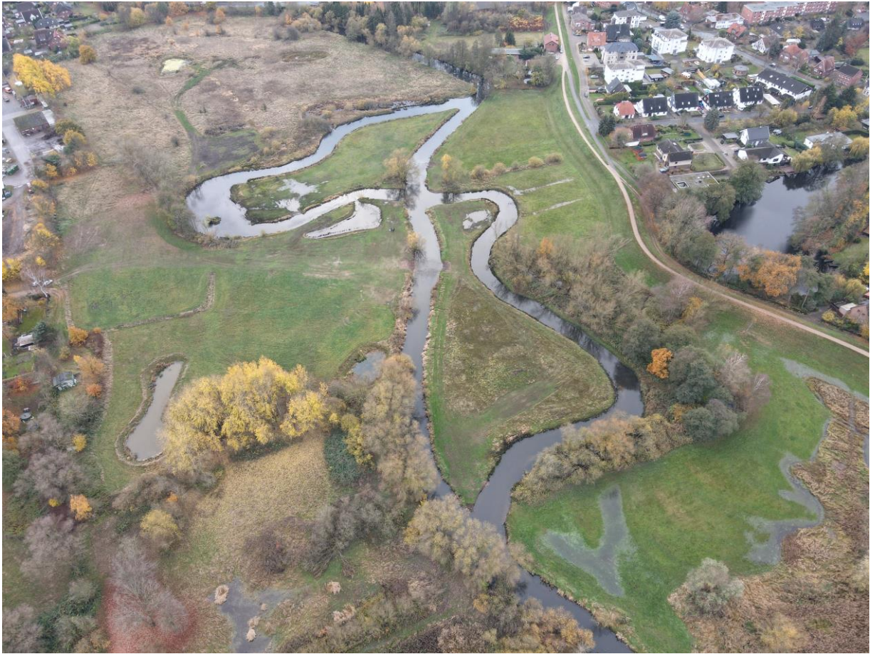
Abb. 1: Blick auf die neuen Luheschleifen und den ursprünglichen Verlauf während den Baumaßnahmen im November 2020
